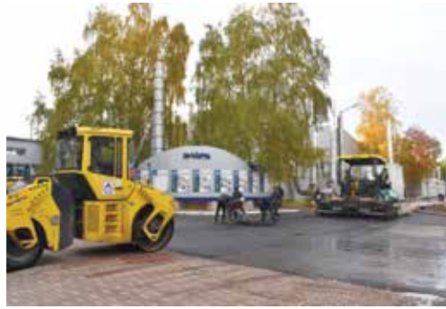
Укладка нового асфальта
