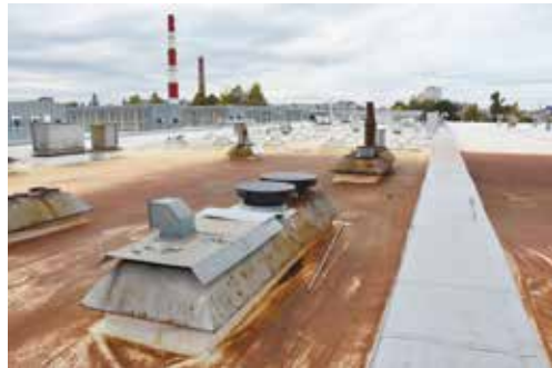
Деформационные швы на кровле корпуса № 1
