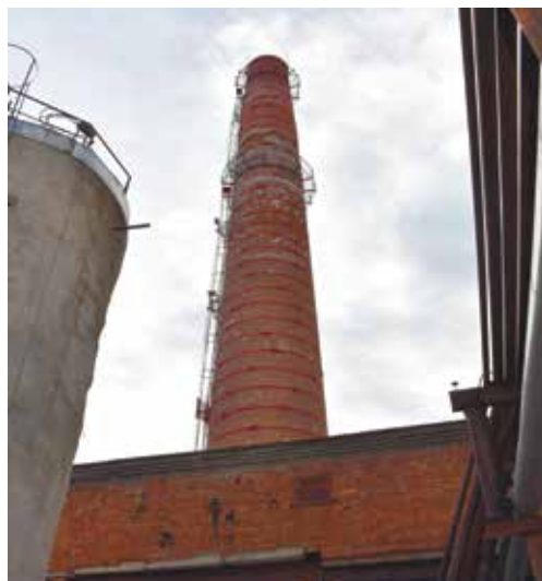
Отремонтированная дымовая труба в котельной
