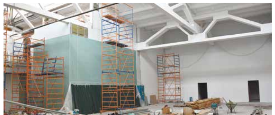
Ремонт помещений для цеха № 110
