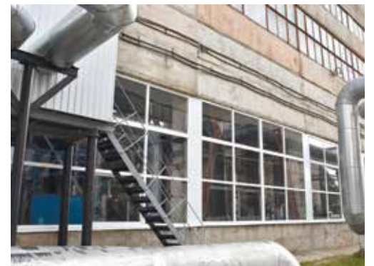
Новые окна в паровой котельной
