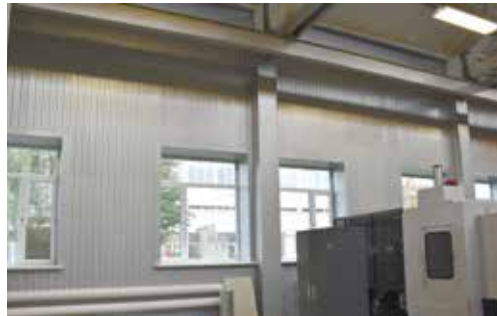
Обновлённая наружная стена цеха № 103
