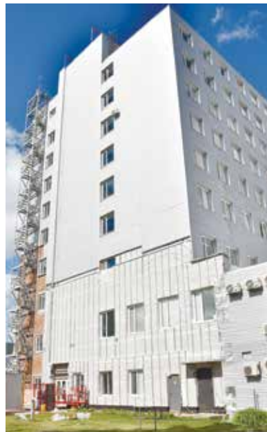
Облицовка фасада корпуса № 3
