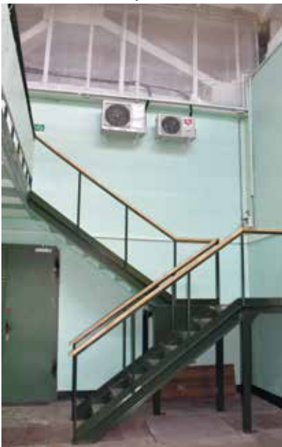
Лестница в корпусе № 1
